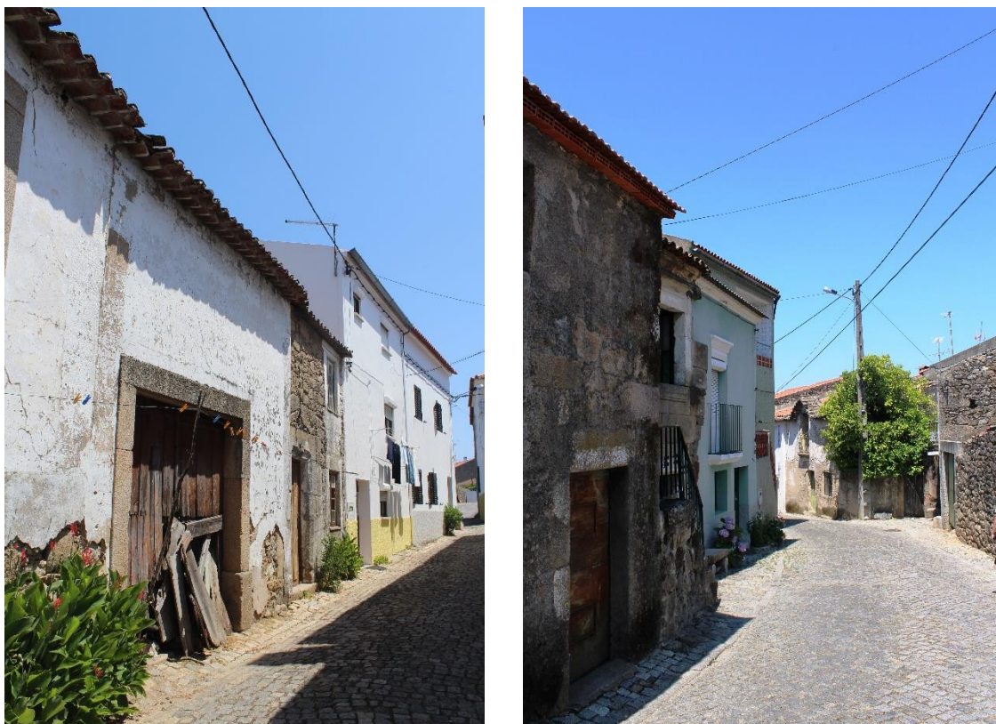
Figura 13. Tecido edificado, Oledo Fonte: SPI, 2015
